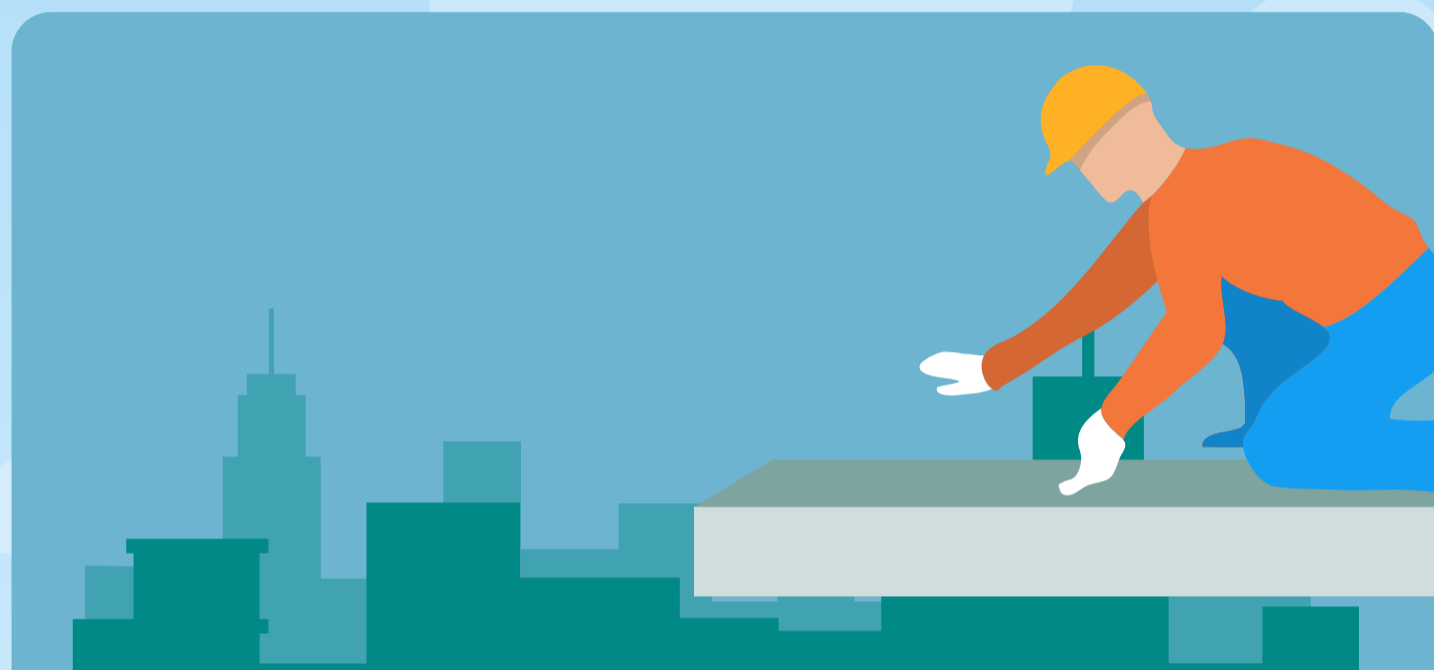
Pekerjaan pada bahan bangunan baja yang menjorok ke luar
